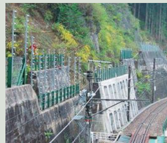
【落石止擁壁と落石警報装置】
