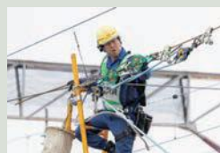
【電力設備復旧訓練】
