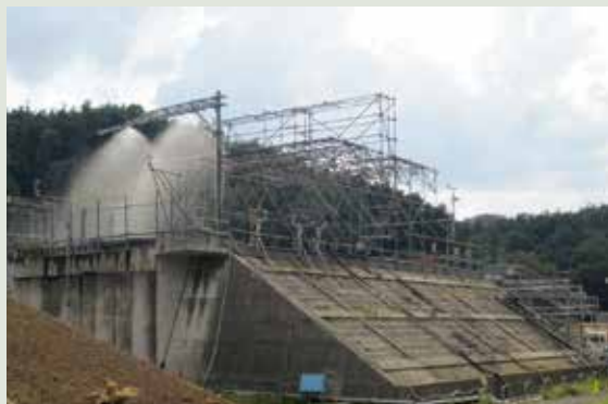
【小牧研究施設の試験盛土】
