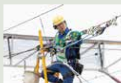
【電力設備復旧訓練】
