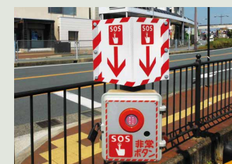
【非常ボタン（踏切支障報知装置）】
