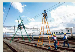
【電力設備復旧訓練】
