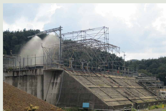
【小牧研究施設の試験盛土】
