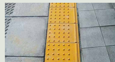
【内方線付き点状ブロック】
