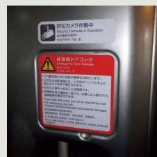
【新幹線の非常用ドアコック設置例】
