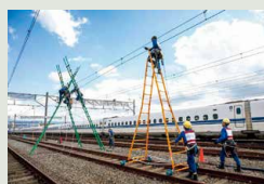
【電力設備復旧訓練】
