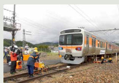
【脱線復旧訓練】
