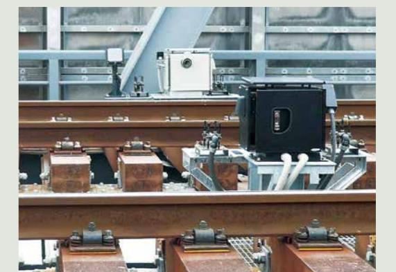
【新幹線台車温度検知装置】
