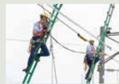
【電力設備復旧訓練】
