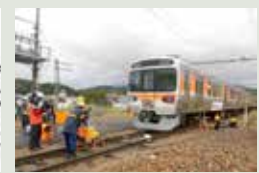
【脱線復旧訓練】
