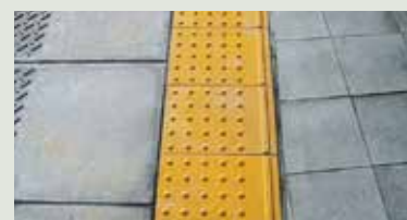
【内方線付き点状ブロック】
