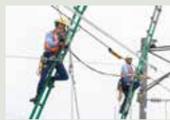
【電力設備復旧訓練】
