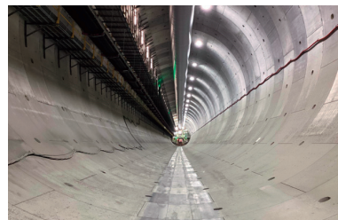
第一首都圏トンネル（梶ヶ谷工区）
