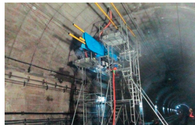
大規模改修工事
