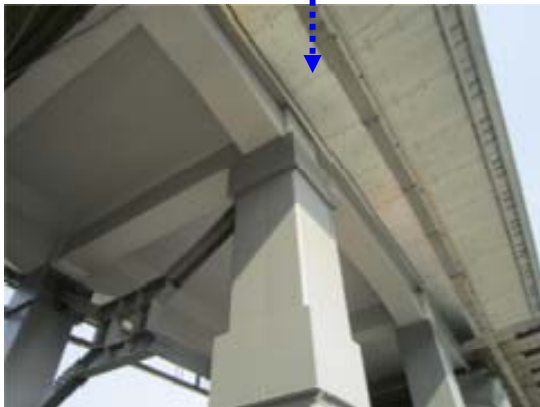
大規模改修工事の例(コンクリート橋)
