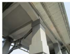
大規模改修工事 (コンクリート橋：変状発生抑止対策)
