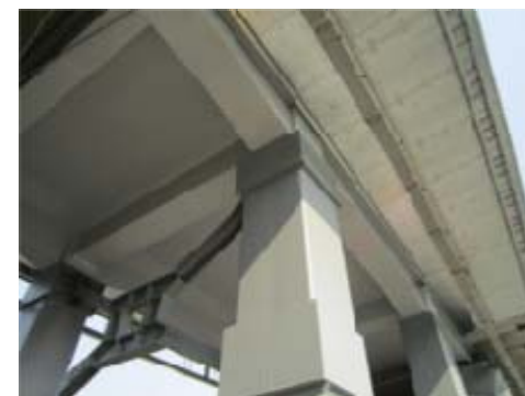
大規模改修工事 (コンクリート橋：変状発生抑止対策)
