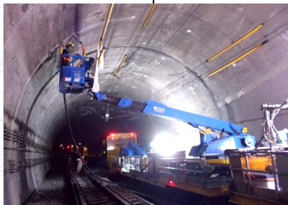
大規模改修工事の例(トンネル)
