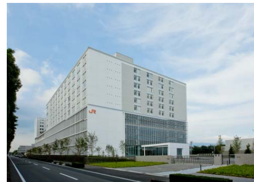
総合研修センター外観
