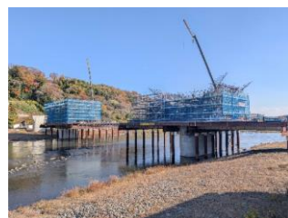
相模川橋りょう 下部工
