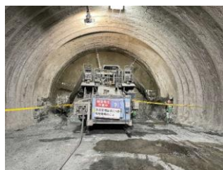
伊那山地トンネル (青木川工区) 本坑掘削工
