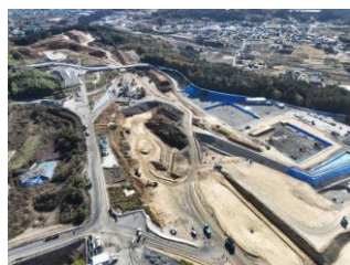
中部総合車両基地 ヤード全景
