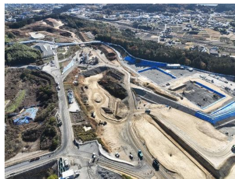
中部総合車両基地 ヤード全景
