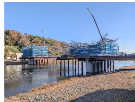
相模川橋りょう 下部工
