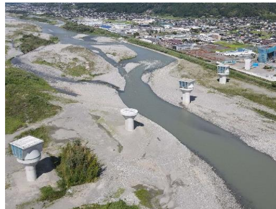
天竜川橋りょう 橋脚工
