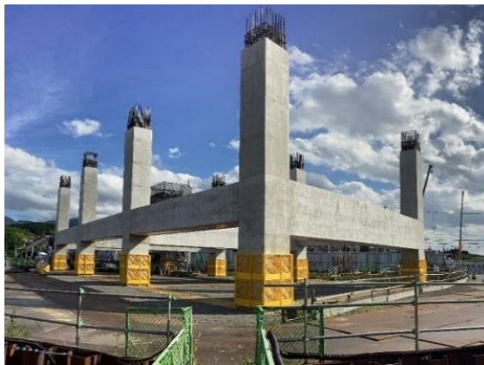
岐阜県駅（仮称） 高架橋工
