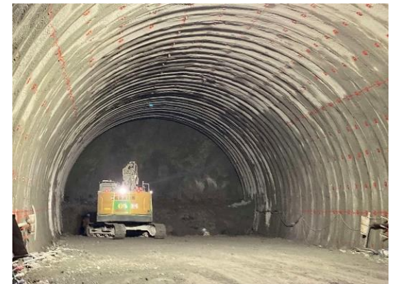
南アルプストンネル (山梨工区) 本坑掘削工
