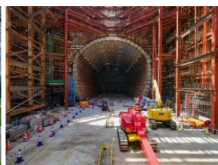
神奈川県駅 (仮称) 函体構築工
