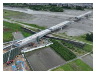
釜無川橋りょう 上部工
