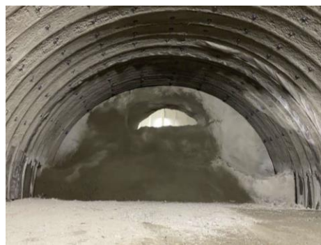
伊那山地トンネル (戸中・壬生沢工区) 本坑の貫通状況
