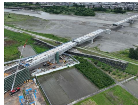
釜無川橋りょう 上部工
