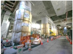
品川駅（非開削工区） 軌道下掘削
