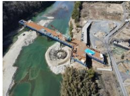
第二木曽川橋りょう 橋脚基礎工
