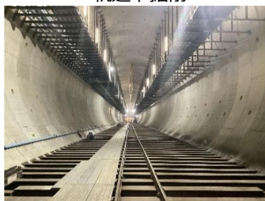
第一首都圏トンネル （東百合丘工区） 本格的な掘進
