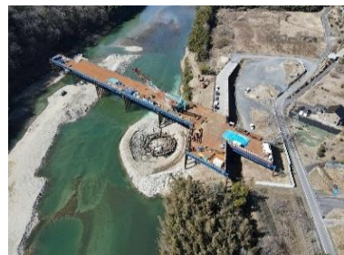
第二木曽川橋りょう 橋脚基礎工
