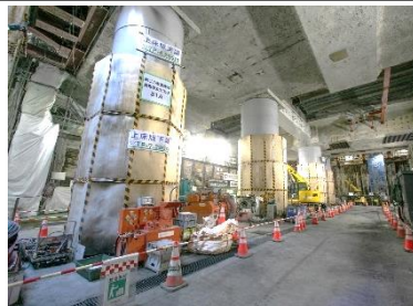
品川駅（非開削工区） 軌道下掘削
