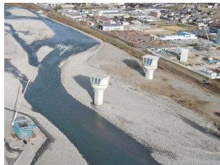
天竜川橋りょう 橋脚工
