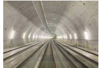
第一首都圏トンネル（北品川工区） 調査掘進完了
