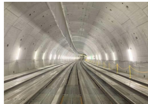
第一首都圏トンネル（北品川工区） 調査掘進完了
