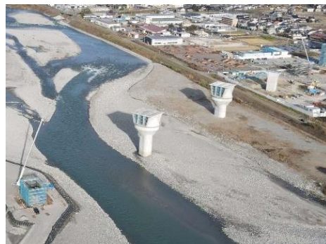
天竜川橋りょう 橋脚工
