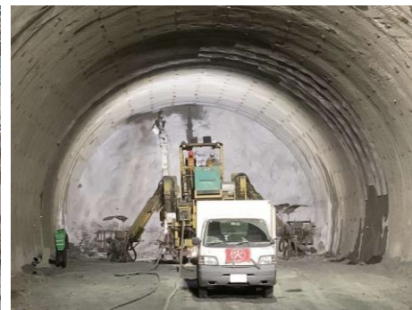
第四南巨摩トンネル (東工区) 本坑掘削工
