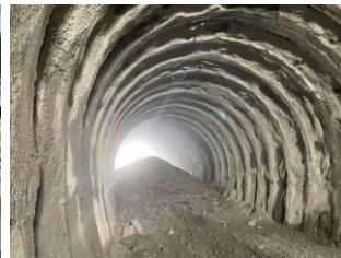
南アルプストーンネル (長野工区) 先進坑貫通 (除山非常口~釜沢非常口)
