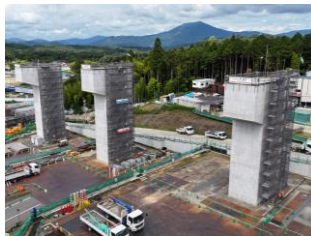
岐阜県駅(仮称) 回送線橋脚工
