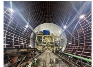
第一首都圏トンネル（小野路工区）調査掘進
