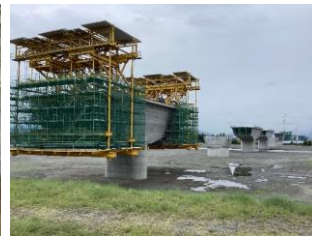
釜無川橋りょう 上部工
