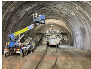
伊那山地トンネル (戸中・壬生沢工区) 本坑掘削工
