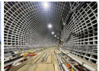
第一首都圏トンネル (梶ヶ谷工区) 本格的な掘進
