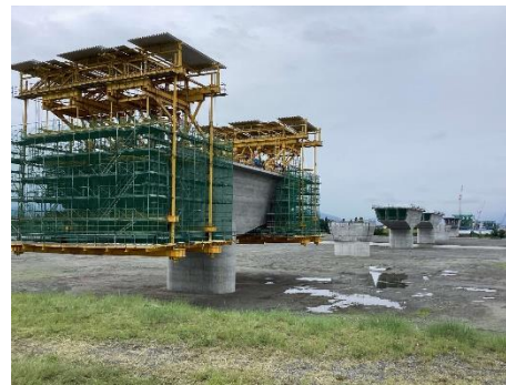
釜無川橋りょう 上部工
