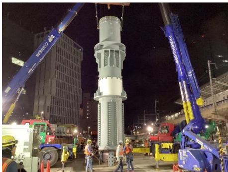
名古屋駅 (中央西工区) 地下駅舎の柱の建込み
