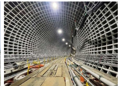
第一首都圏トンネル (梶ヶ谷工区) 本格的な掘進
