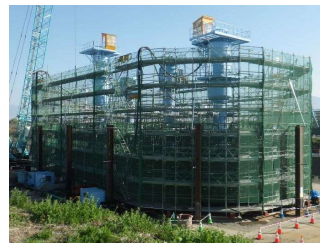
笛吹川・濁川橋りょう 橋脚工
