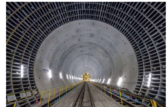
第一首都圏トンネル 東百合丘工区
