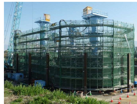
笛吹川・濁川橋りょう 橋脚工
