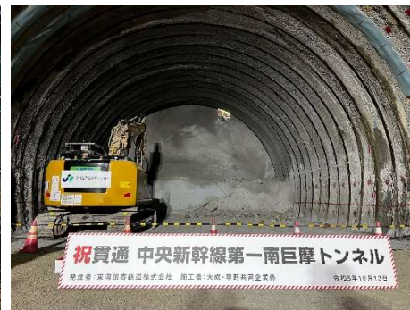
第一南巨摩トンネル 本坑掘削工 (10/13貫通)
