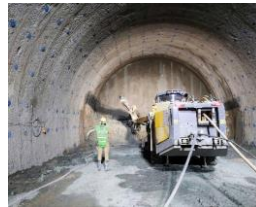
神奈川県内 藤野トンネル 本坑掘削工
