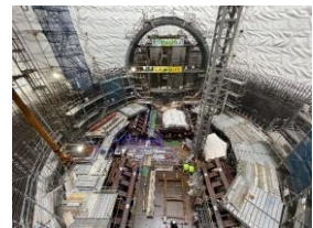
東雪谷非常口 躯体構築工
