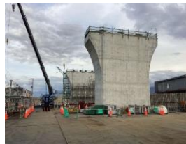
山梨県内 白井河原高架橋 橋脚工
