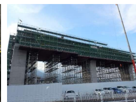
山梨県内高架橋 上部工
