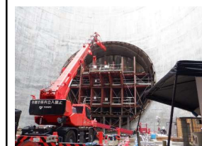
第一中京圏トンネル(名城工区) シールド掘進準備工
