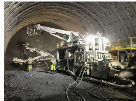
南アルプストンネル（長野工区） 本坑掘削工
