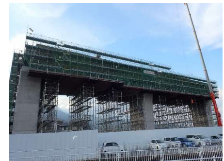
山梨県内高架橋 上部工
