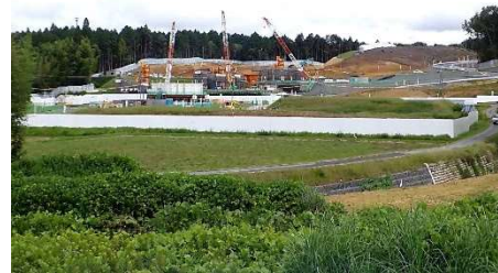
岐阜県駅（仮称） ヤード全景
