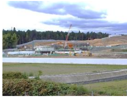
岐阜県駅（仮称） ヤード全景
