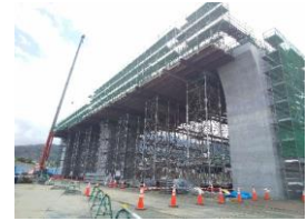
山梨県内高架橋 上部工
