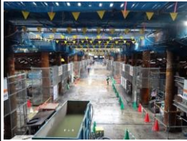
名古屋駅 中央東工区 軌道下掘削工
