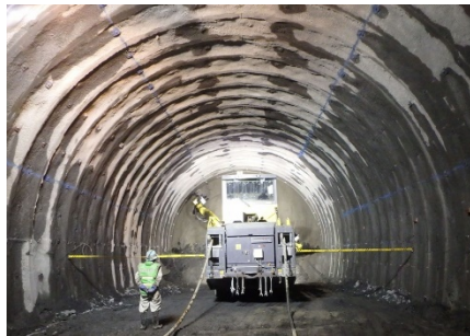
南アルプストンネル (山梨工区)
