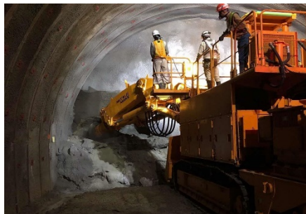
日吉トンネル (南垣外工区)
