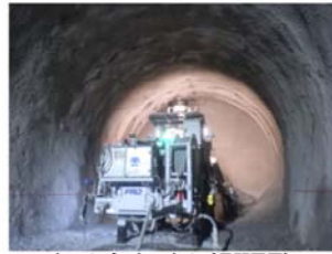
南アルプストンネル（長野工区）
