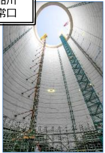
掘削完了、躯体構築
