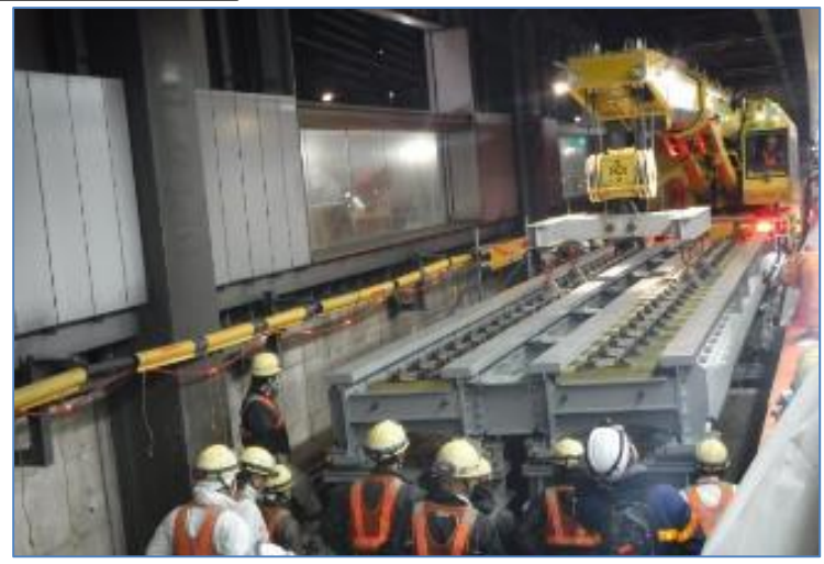
工事桁架設
