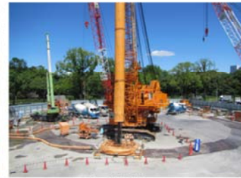
名城非常口 (地中連続壁工)
