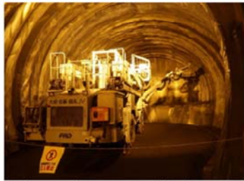
南アルプストンネル(山梨工区) (先進坑掘削)
