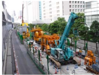
品川駅 (地下駅の地中連続壁工)
