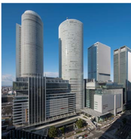
JRセントラルタワーズ（中央・左）とJRゲートタワー（右）
