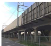
大規模改修工事(コンクリート橋)
