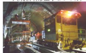
大規模改修工事(トンネル)
