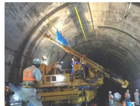
大規模改修工事(トンネル内ロックボルト施工)
