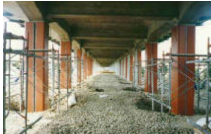
新幹線高架橋柱の耐震補強
