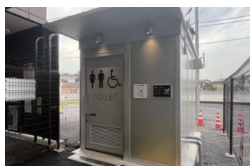
東武鉄道 葛生駅 旅客トイレ
