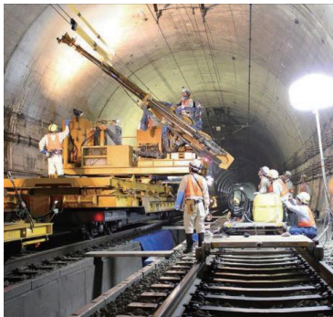
大規模改修工事
