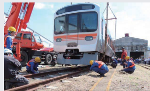
脱線復旧訓練
