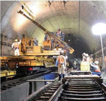
大規模改修工事
