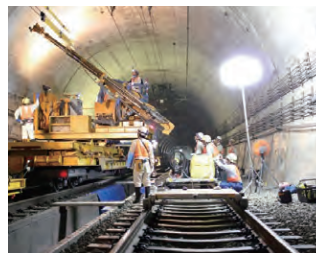
大規模改修工事
