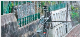
落石止擁壁と落石警報装置
