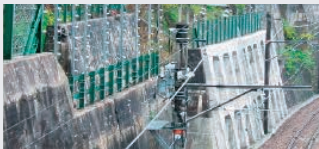
落石止擁壁と落石警報装置
