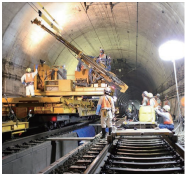
大規模改修工事
