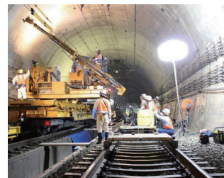
大規模改修工事
