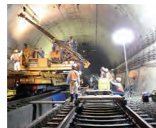
大規模改修工事
