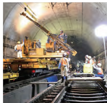
大規模改修工事
