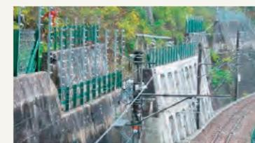
落石止擁壁と落石警報装置
