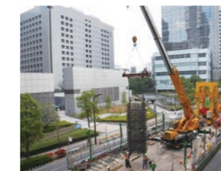
品川駅:地中連続壁の構築
