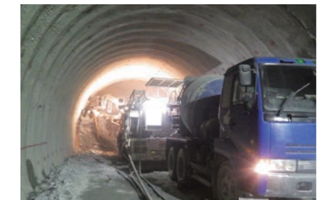
南アルプストンネル(長野工区)斜坑の掘削
