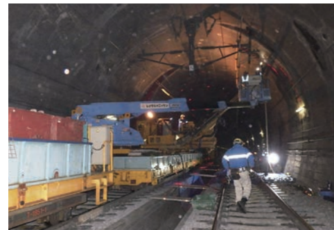
大規模改修工事
