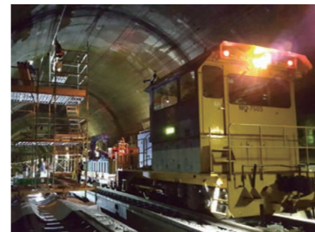
大規模改修工事
