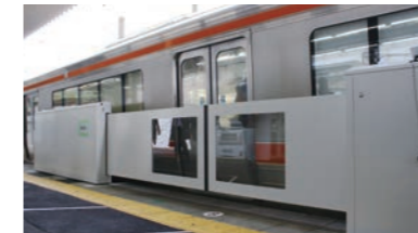
金山駅で実証試験中の可動柵
