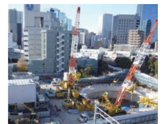
北品川非常口:立坑の掘削
