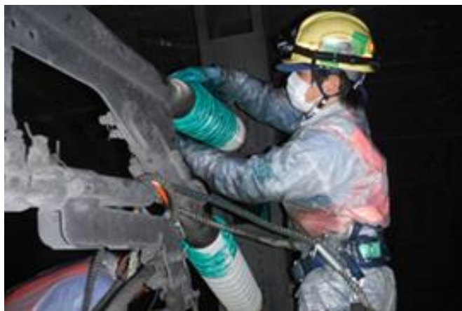
写真1 シリコンコンパウンド塗布作業
